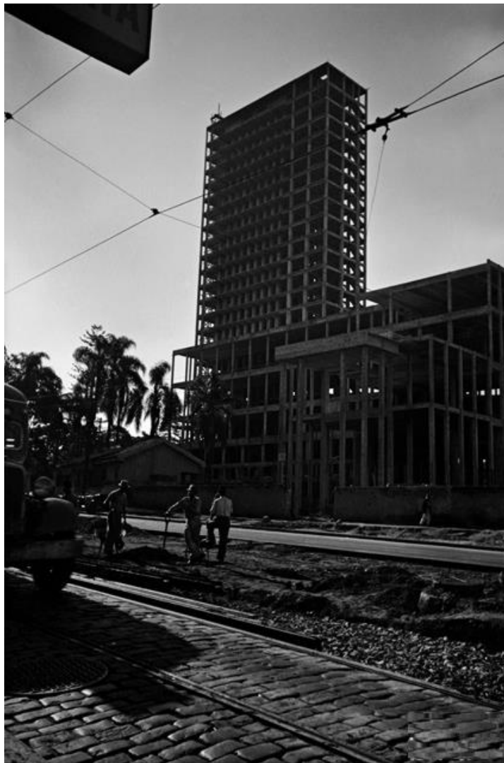
Imagem 3: Biblioteca Municipal em construção, na rua da Consolação, São Paulo, SP, 1940. Fotógrafa: Hildegard Rosenthal.
