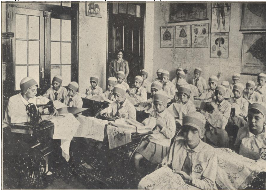
Figura 04 - Escola G. E. Joaquim de Assumpção – aula de trabalhos manuais
