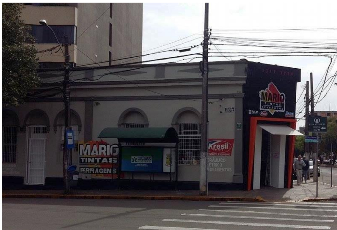
Figura 1 - Fachada de prédio histórico. Fonte – Arquivo pessoal.
